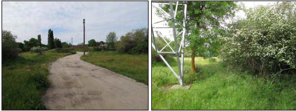
Fotografía 184.- Camino de acceso al apoyo nº 412.
