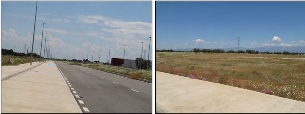
Fotografía 28.- Camino de acceso al apoyo nº 45 dentro del desarrollo industrial "Expacionavalmoral"
