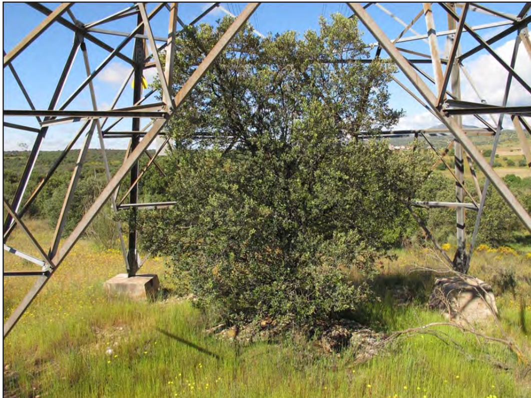
Fotografía.- Apoyo nº 305.
