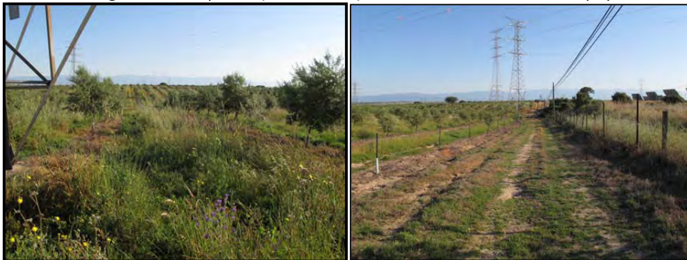
Fotografía 5.- Camino de acceso al apoyo nº 7.
