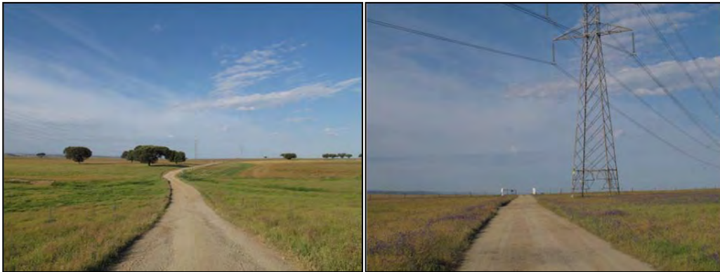
Fotografía 72.- Camino de acceso al apoyo nº 130.
