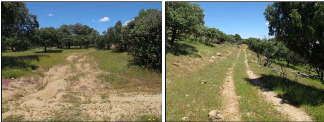
Fotografía 123.- Camino de acceso al apoyo nº 263.
