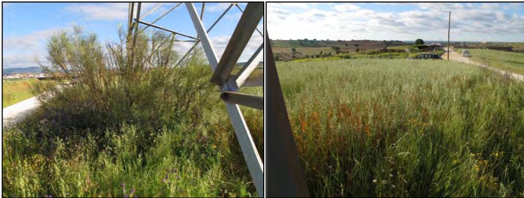
Fotografía 144.- Camino de acceso al apoyo nº 312.
