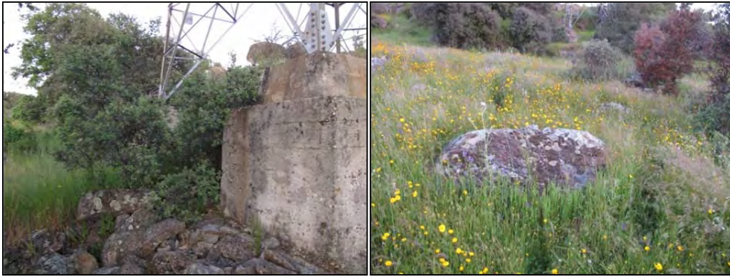
Fotografía 102.- Camino de acceso al apoyo nº 211.
