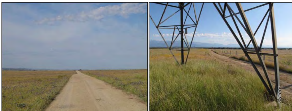
Fotografía 70.- Camino de acceso al apoyo nº 129.
