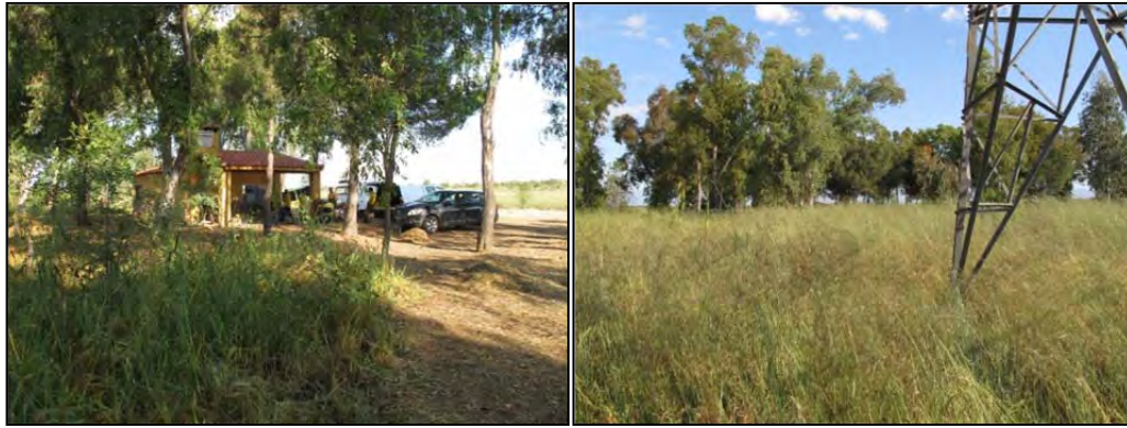
Fotografía 68.- Camino de acceso al apoyo nº 125.
