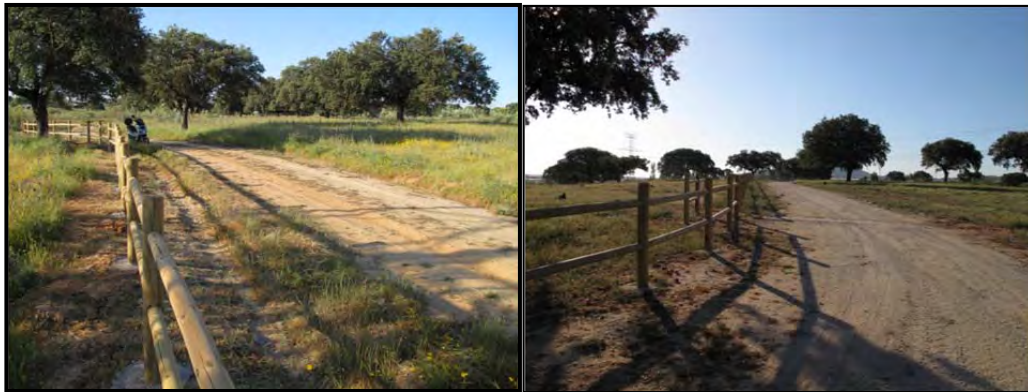
Fotografía 2.- Camino de acceso al apoyo nº 4.
