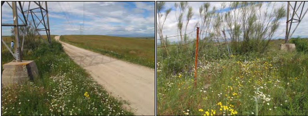
Fotografía 176.- Camino de acceso al apoyo nº 388.
