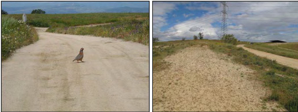
Fotografía 178.- Camino de acceso al apoyo nº 390.
