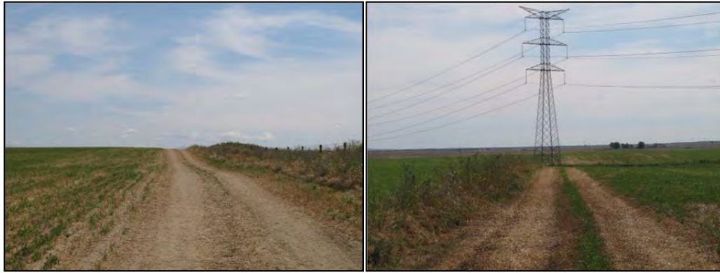
Fotografía 66.- Camino de acceso al apoyo nº 122.
