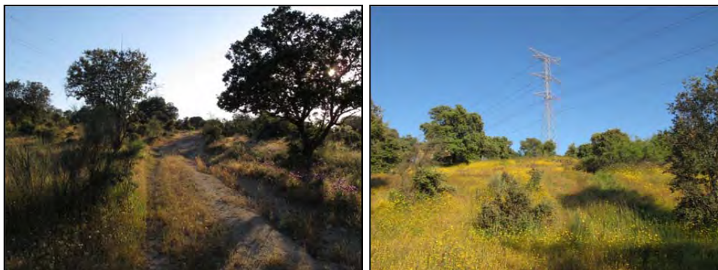
Fotografía 95.- Camino de acceso al apoyo nº 187.
