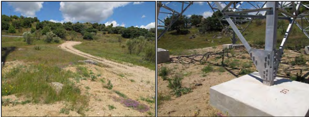
Fotografía 125.- Camino de acceso al apoyo nº 273.
