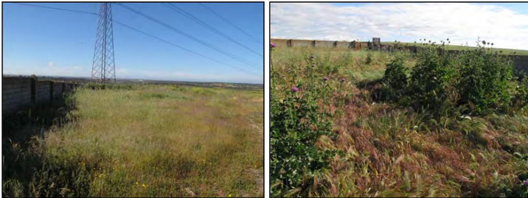
Fotografía 140.- Camino de acceso al apoyo nº 308.
