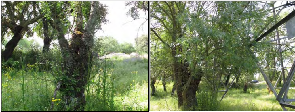
Fotografía 85.- Fresnos a necesario talar y podar entorno al apoyo nº 143.
