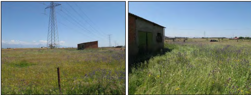
Fotografía 26.- Camino de acceso al apoyo nº 45.
