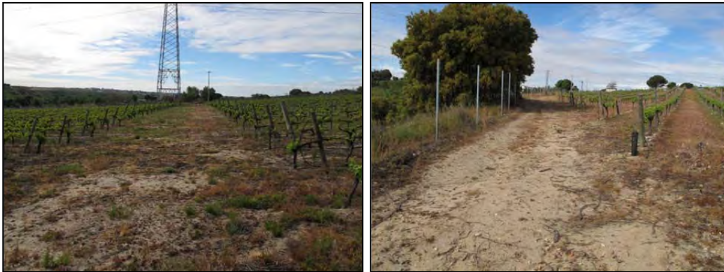
Fotografía 182.- Camino de acceso al apoyo nº 411.
